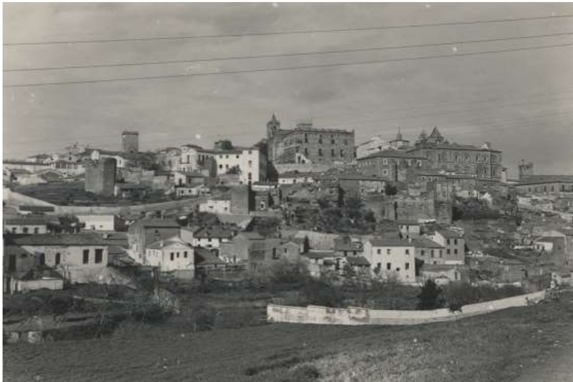
Fig 24. Panorámica del lienzo oriental de la cerca almohade, donde se concentran un buen número las intervenciones consignadas en el informe de la comisión municipal con fecha de 1 de diciembre de 1837.
