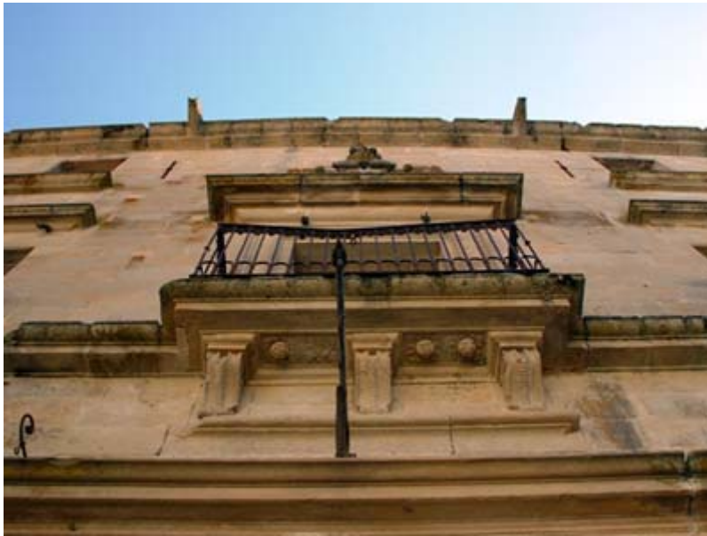
Detalle de la fachada principal de las casas de Juan Pizarro de Aragón.
