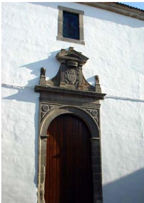
Fachada septentrional del convento de la Merced
