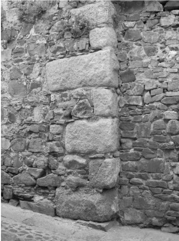
Fig. 9. Sillares reaprovechados junto al Arco de la Estrella
