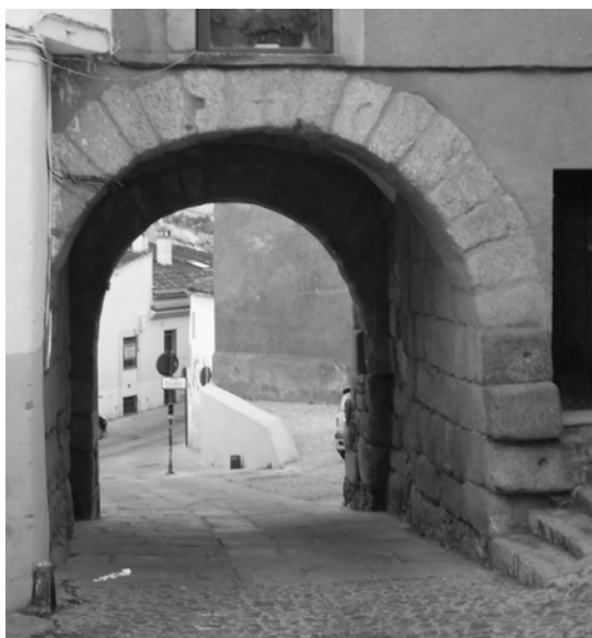
Fig. 3. Vista intramuros del Arco del Cristo
