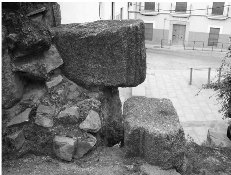
Fig. 7. Antiguas cornisas romanas reaprovechadas en la construcción de la muralla
