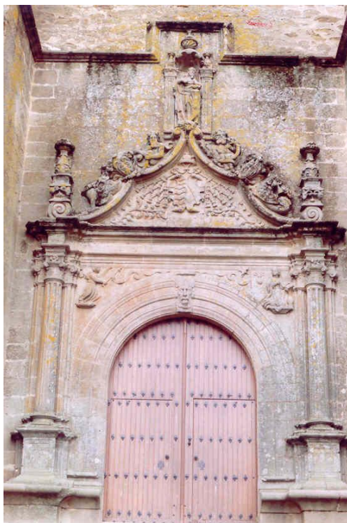
Lámina XI Fachada de la parroquia de Malpartida de Plasencia
